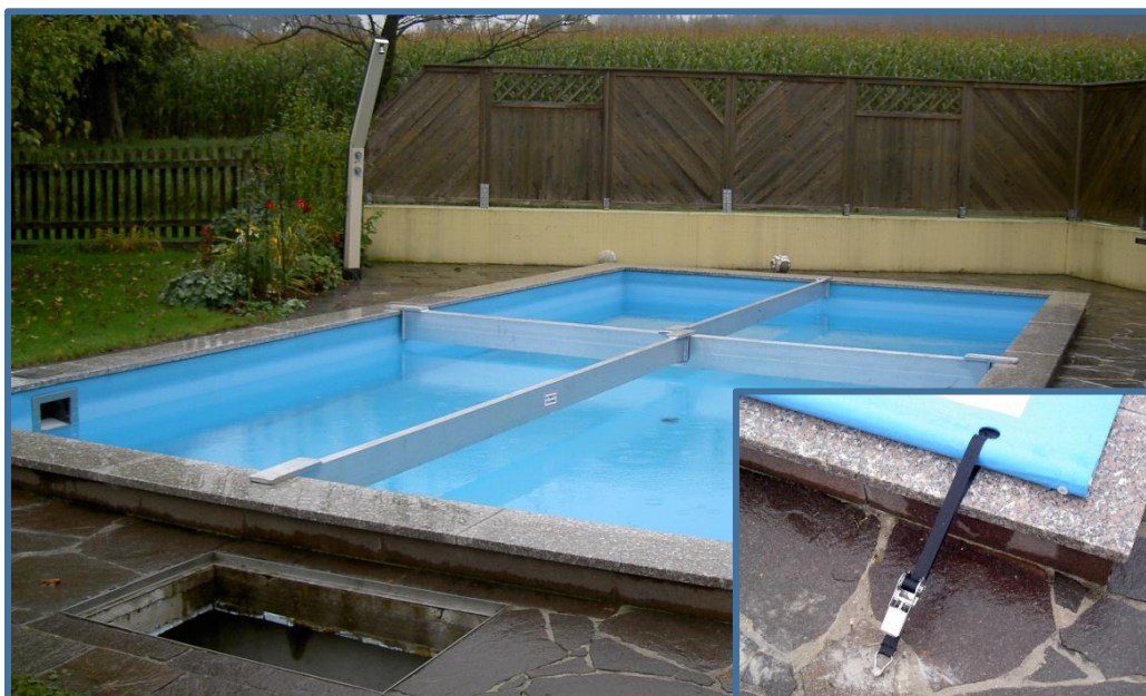
Rollschutz mit Winterkruz als Winterabdeckung nutzen. 100 kg/m 2
